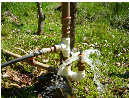
Detalhe do carneiro hidráulico
